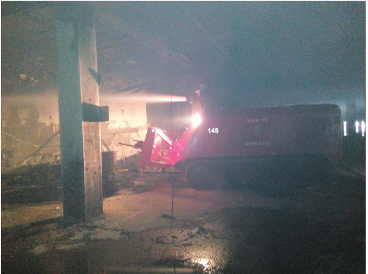
Рис. 3. Аварийно-спасательные работы РТК ЕЛЬ-10 в ТЦ «Синдика»
