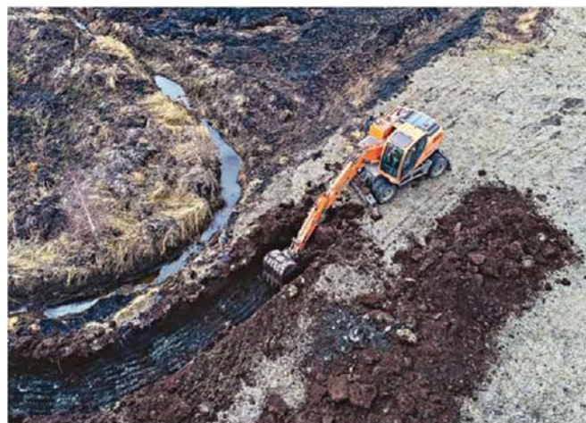
Рис. 5. Правильная локализация очага канавой до минерального грунта (отвал наружу). Между отвалом и канавой оставлен проход
