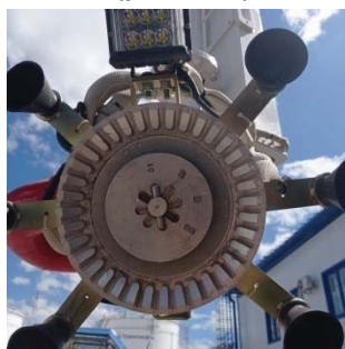
Рис. 13. Пожарный лафетный ствол для подачи пены низкой кратности ЛСД-С100У
