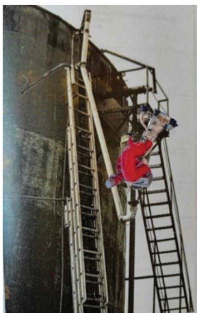
Рис. 14. Модули трехколенной лестницы и пожарного лафетного ствола для подачи пены в вырезанное окно стенки горящего резервуара с нефтепродуктами
