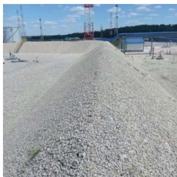
Рис. 6. Обвалование вокруг резервуара с нефтепродуктами разного типа
