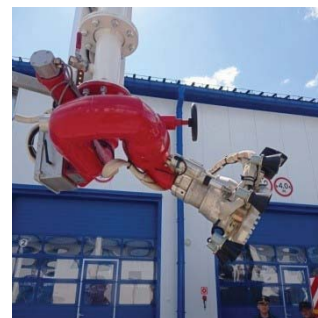
Рис. 13. Пожарный лафетный ствол для подачи пены низкой кратности ЛСД-С100У
