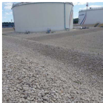
Рис. 7. Основание резервуара с нефтепродуктами
