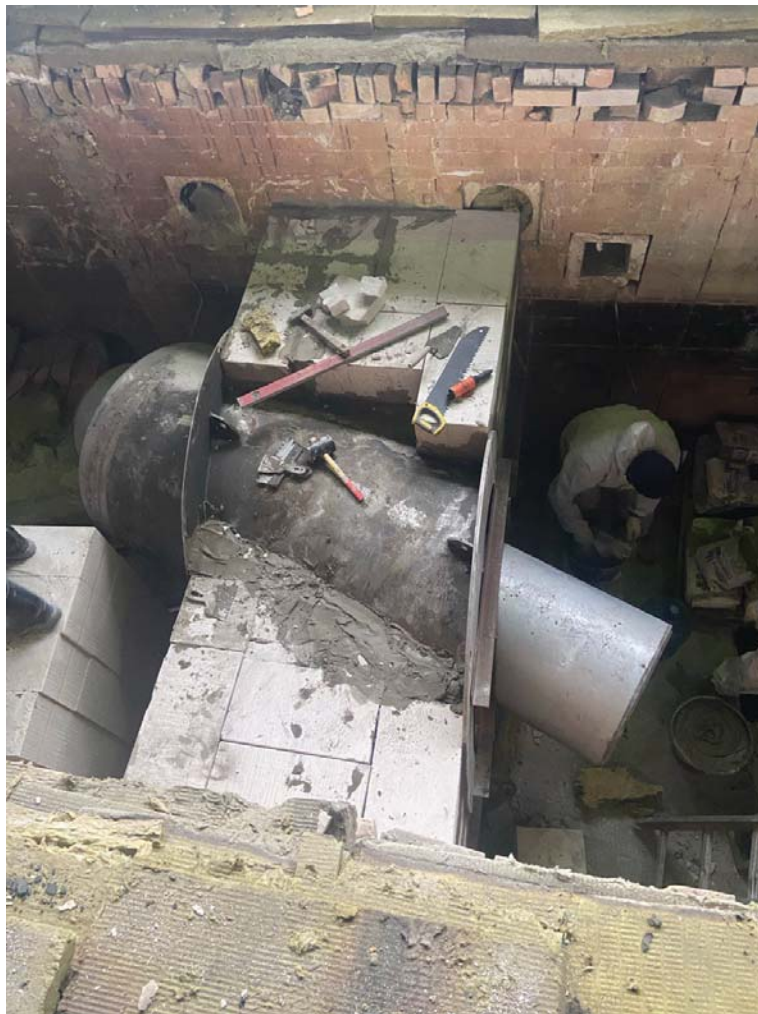
Рис. 1. Монтаж проходок с размерами 630×45 и 65×8 мм в огневой камере
