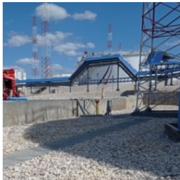
Рис. 3. Обвалование вокруг нефтеналивного резервуара разного типа
